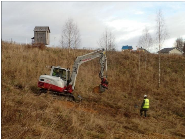
Koneellista kaivuuta tutkimusalueen alaosassa. Koilliseen.
